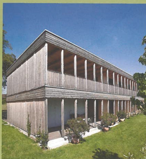
Oben: Ansicht des Holzhauses von der Gartenseite
