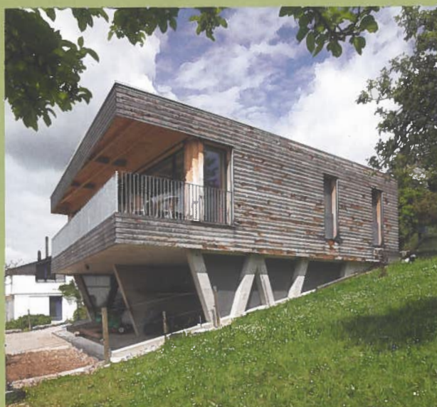
Oben: Die V-förmigen Betonstützen verleihen dem Wohngeschoss optische Leichtigkeit. Im offenen Untergeschoss sind die beiden Pferde untergebracht.
